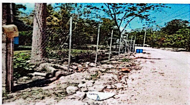
REPARACION DE ALAMBRE DE PUA
