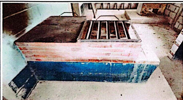
SUSTITUCION DE PLANCHA DE METAL DE 3 HORNILLAS
