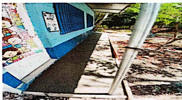
SUSTITUCION DE PISO DE TORTA DE CONCRETO
