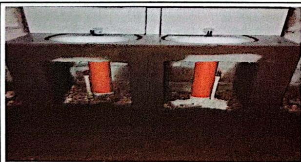
SUSTITUCIÓN DE LAVAMANOS
