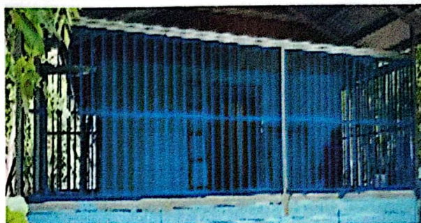
SUSTITUCIÓN DE BALCON DE METAL
