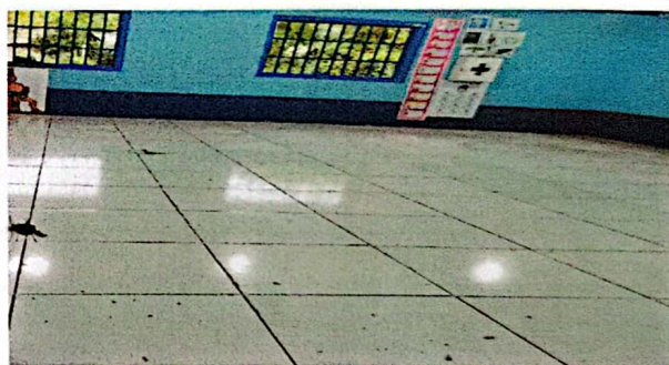
SUSTITUCIÓN DE CERÁMICO
