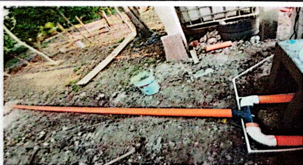
REPARACION DE TUBERIA PRINCIPAL DE DRENAJE
